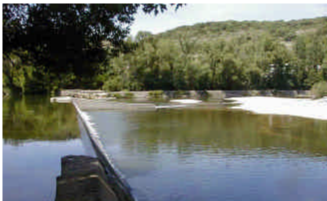
7. Seuil de sous-Roche, 2 ème seuil à l'aval de Lanas. Frayère sur le radier au niveau du banc de galets en aval du seuil en RG (>60 aprons de l'année en été 2007).
