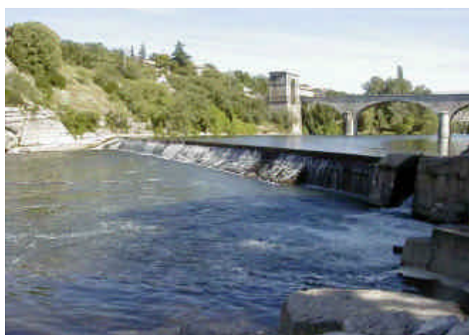
4. Seuil des anciennes brasseries de Ruoms, 1 er seuil en aval de Lanas.
