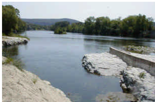
8. L'Ardèche en aval du seuil de Mas-Neuf. L'aval du seuil est sous l'influence du seuil de Gos, d'où l'absence de zones courantes favorables à l'Apron.
