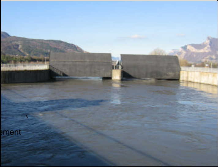
Vannes de fermeture de la prise d'eau
