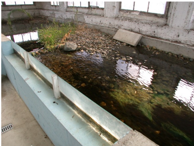
Figure 25 Photo de la zone du radier avant installation du canal
