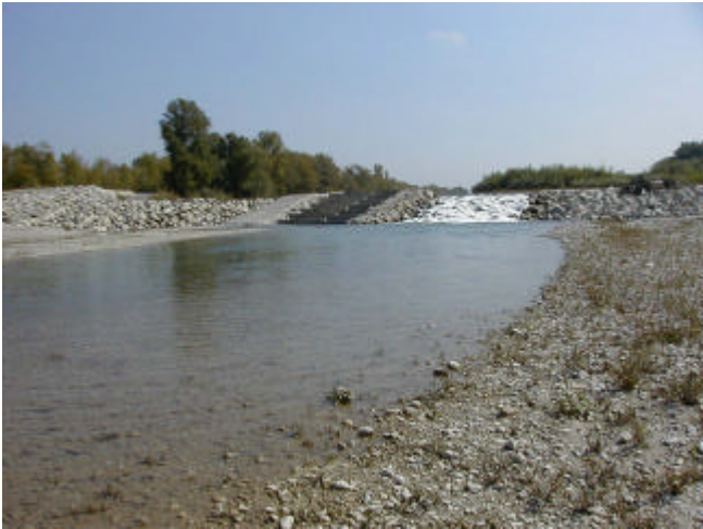
Le seuil CNR de Livron avec sa passe à poissons au centre
