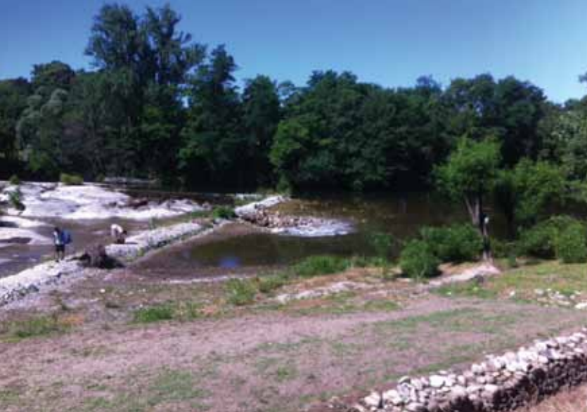
Photos 17 : Ouverture de l'arche centrale du seuil de Rosières © SRBD
