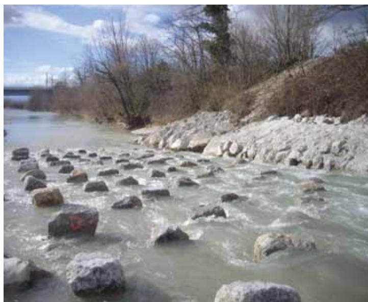
Photos 20 : Passe à poissons du seuil SMARD © SMRD
