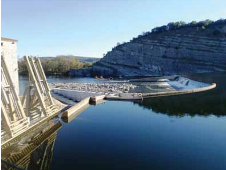
Photos 15 : Passe à poissons du seuil de Mas-neuf © M. Georget
