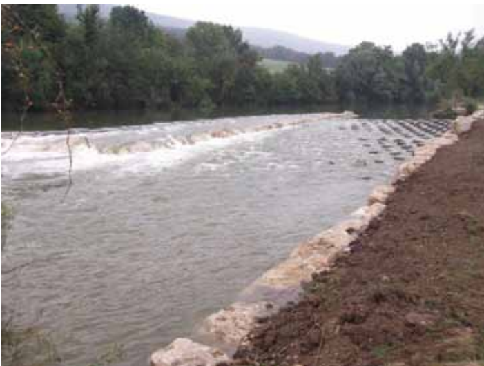
Photos 18 : Passe à poissons du barrage de Bellerive © SMIX Loue
