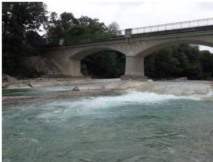
Photos 21 : Passe à poissons au niveau du radier de pont de la D164 © M. Georget
