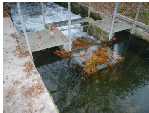
Photographie 1 : Colmatage par des algues et des sédiments fins
