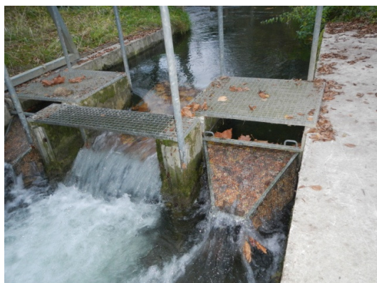
Photographie 2 : Colmatage par des feuilles, surverse et formation d'une chute
