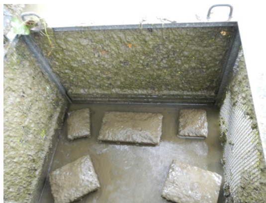
Photographie 1 : Colmatage par des algues et des sédiments fins
