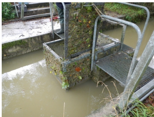
Photographie 1 : Colmatage par des algues et des sédiments fins
