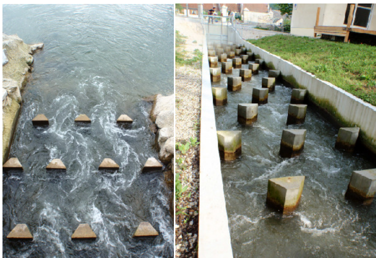
Figure 8 : Partie aval (à gauche) et amont de la passe à poisson de Quingey
