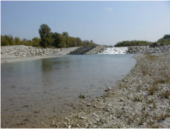
Le seuil CNR de Livron avec sa passe à poissons au centre
